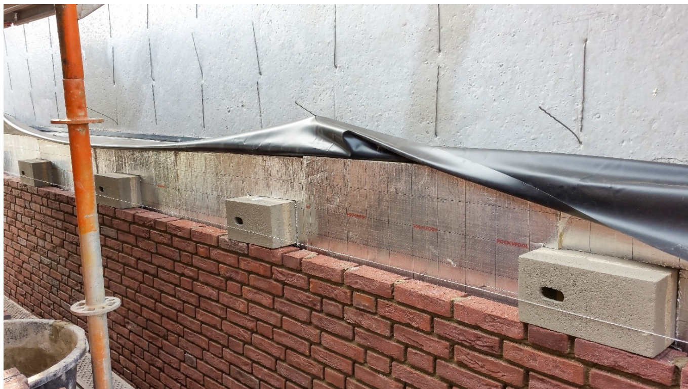
Gierzwaluwkasten (van Vivara Pro) worden ingemetseld in een muur met isolatie (Bron: Vivara Pro)
