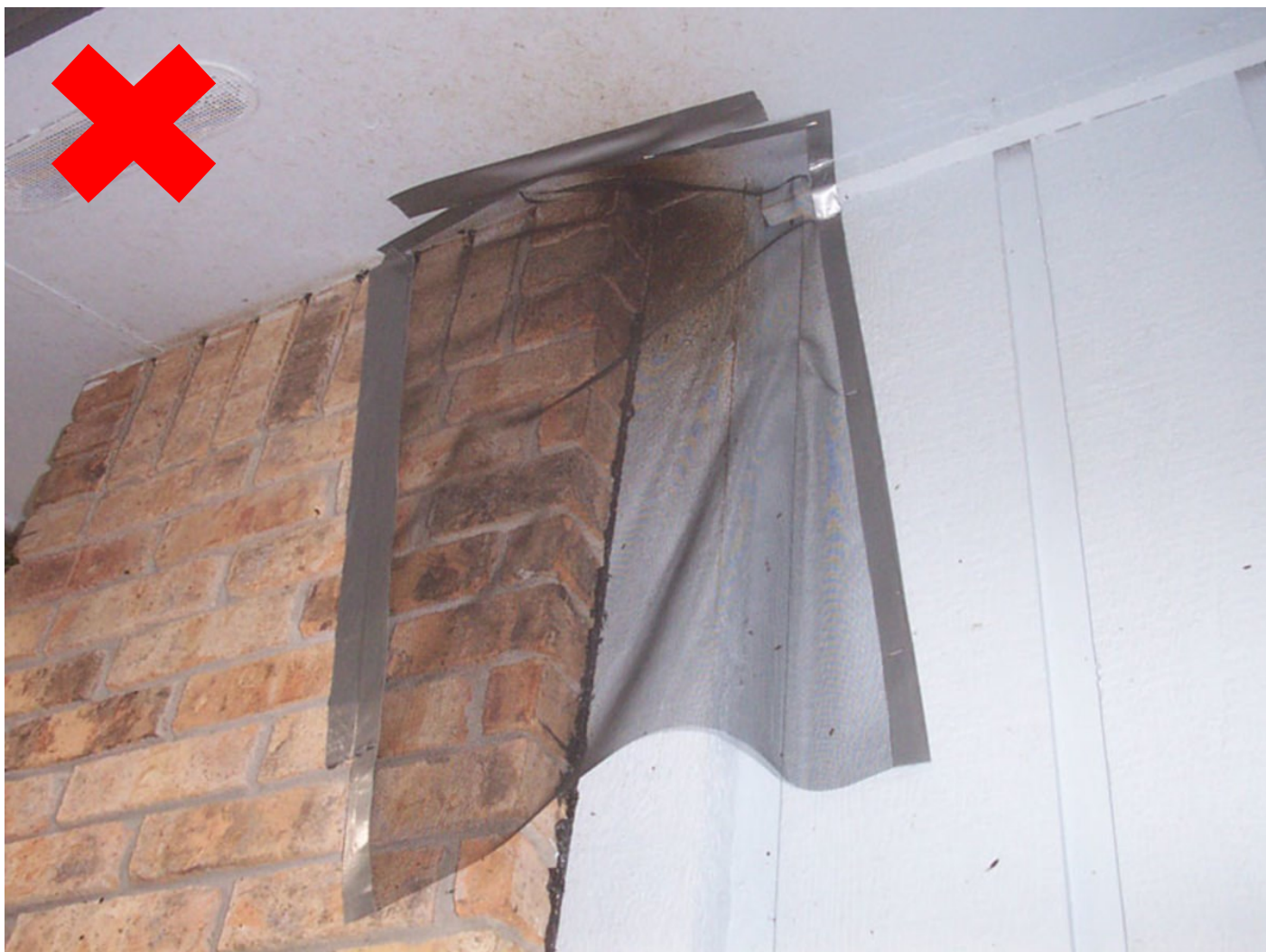
Figuur 4 Foutieve toepassing van exclusion flaps
