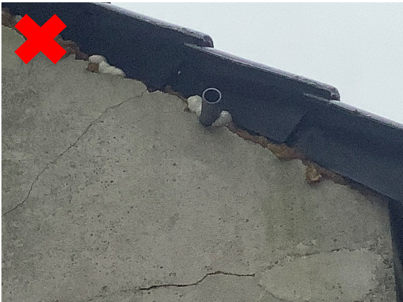
Figuur 5 Foutieve 'exclusion flap' (het pijpje)
