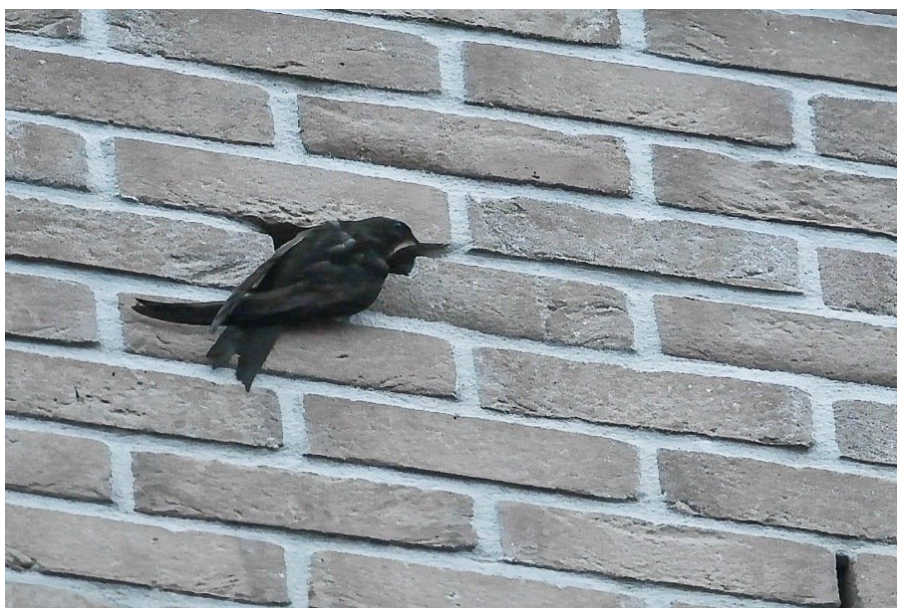
Een in gebruik zijnde inbouwsteen achter de gevelstenen. In de gevel is een opening gemaakt voor de gierzwaluw (Bron: Vivara Pro)
