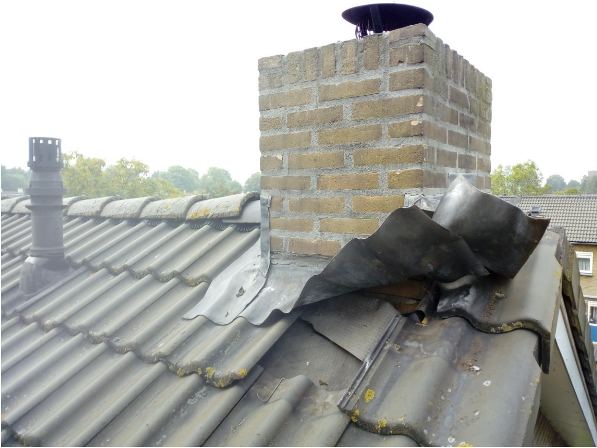
Paarverblijf gewone dwergvleermuis onder loodslab. Project van St Joseph in Boxtel (Bron: Arcadis)
