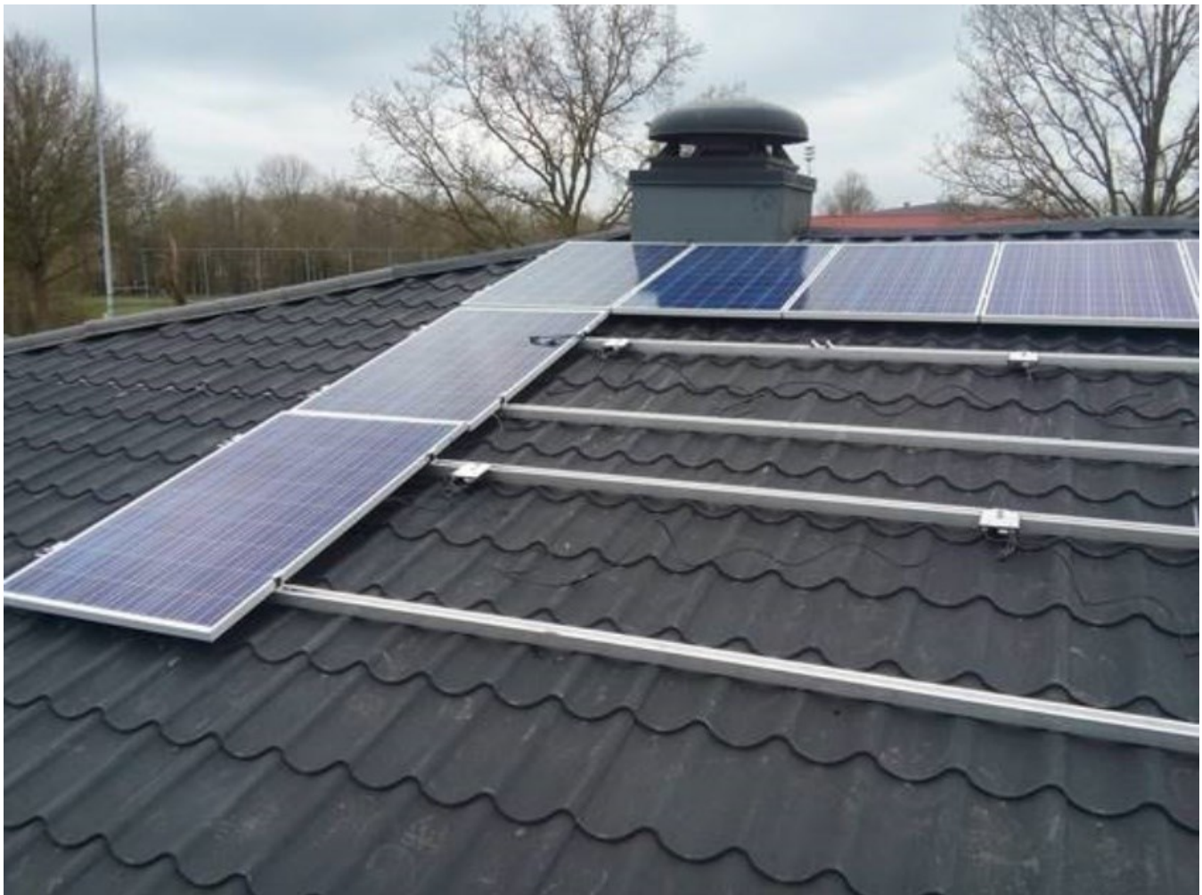
Figuur 11 Horizontale bevestigingslatten onder zonnepanelen
