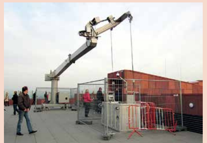
► De meeste gevelonderhoudsinstallaties met een dakwagen zijn bevestigd op het dak.
