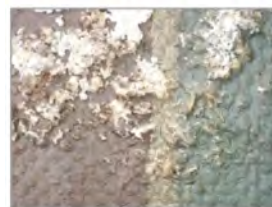
6 doorslag opgezwollen lijm en verflaag doek Z-ZW links 46
